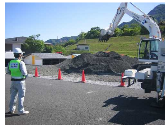
中部地整の無人化施工バックホウによる土砂撤去
