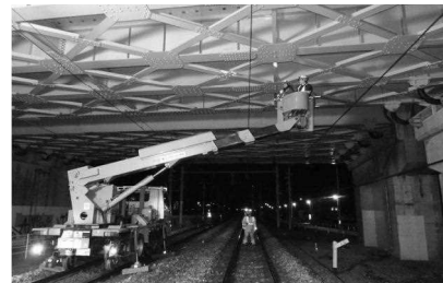
<跨線橋の計画的な点検>
