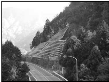
<斜面崩落防止対策>
