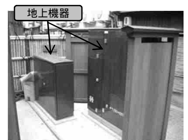
地上機器 民地を活用した地上機器の設置
