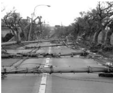
<電柱の倒壊による道路閉塞>
