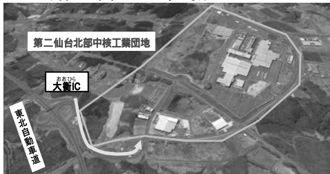
<高速道路に直結している主要施設の例>
