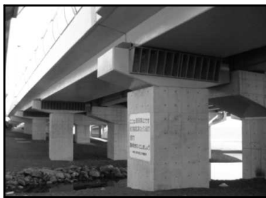
<橋梁の耐震補強>
