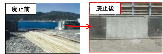
集約化等により利用度の低い陸閘を完全に廃止
