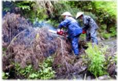
支障木の除去
