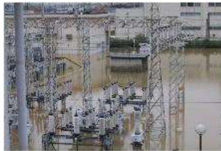
平成16年9月 東海豪雨で浸水した変電所
