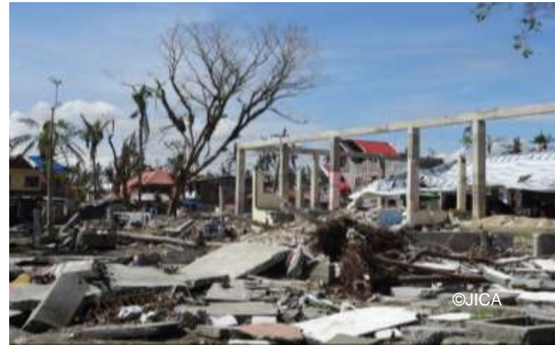
サンアントニオ周辺の被災状況
