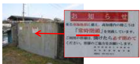
利用度の低い陸閘を常時閉鎖
