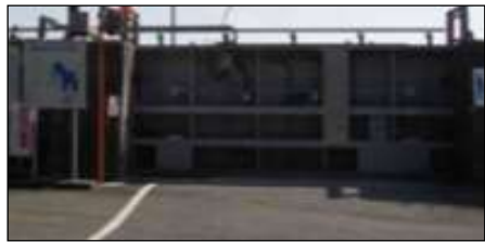
【陸閘の自動化の例(三重県)】
