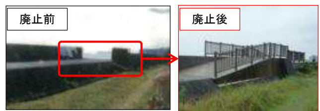
スロープを設置し陸閘を廃止
