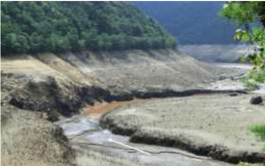
H25.9.1 湖底が現れた宇連ダム (出典)平成25年度中部地方ダム等管理フォローアップ委員会資料 国土交通省中部地方整備局 独立行政法人水資源機構
