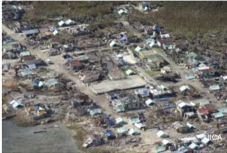
ギゴソ周辺の被害状況
