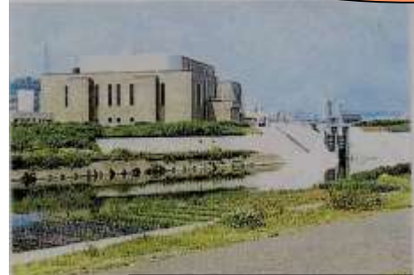
内水排除施設
