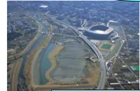
洪水調節施設
