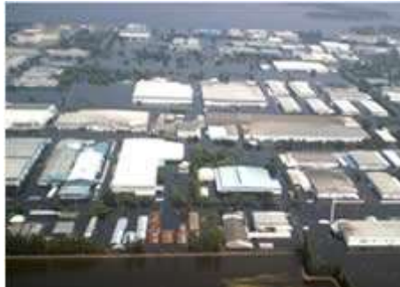
平成23年10月 タイ国の洪水でロジャナ工業団地の浸水状況
