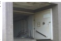
【地下鉄出入口の防潮扉】
