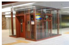
【エレベーター】
