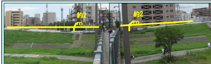
局所的に低い堤防の嵩上げの実施(橋梁部周辺が約2m低い)
