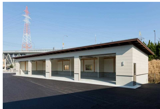
神戸税関境支署(車庫棟)
