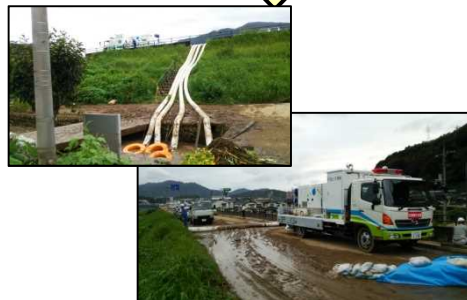
排水ポンプ車による緊急排水状況 （H26広島市土砂災害）
