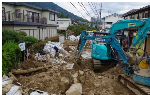
被災地の排水のための八木用水の土砂撤去 (8月31日)
