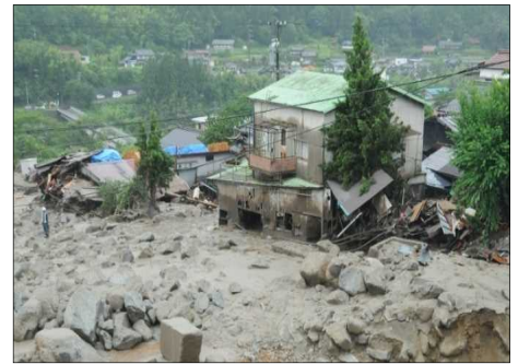
土石流による家屋の被災状況
