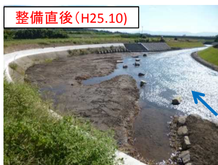
整備直後(H25.10) 断面の余裕を活用しワンドを造成 水衝部には根固を配置
