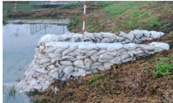
水がひいた後の「月の輪工法」の状況 (10月8日)
