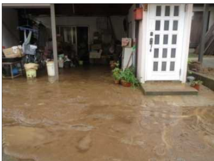
家屋浸水状況
