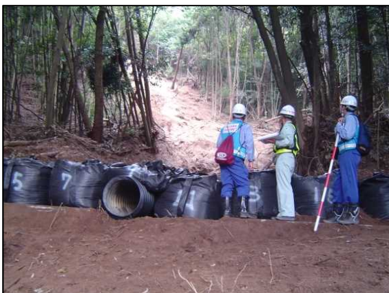
大型土のう設置 （広島市土砂災害）（9月6日）
