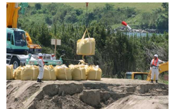
大型土嚢による堤防復旧訓練(四国)
