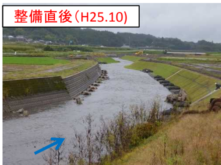
整備直後(H25.10) 既設護岸保護のための根固め ブロックをとびとびに据え付け
