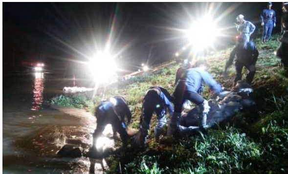
まち側の堤防法尻から漏水した箇所で大防活動を実施 (10月6日)
