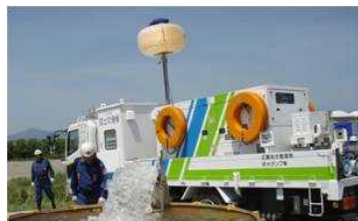
排水ポンプ車による緊急排水(近畿)
