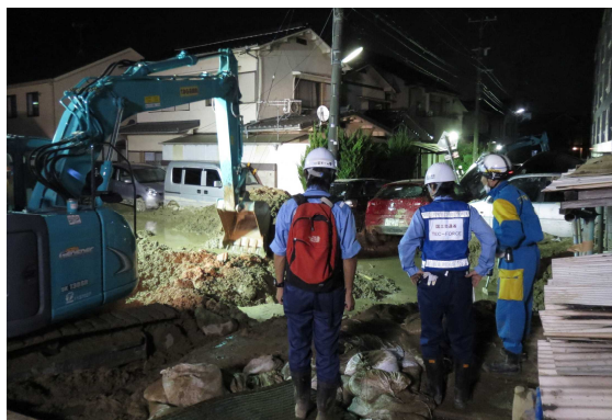
道路啓開の状況 (8月30日)
