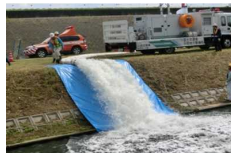
緊急排水訓練(中部)
