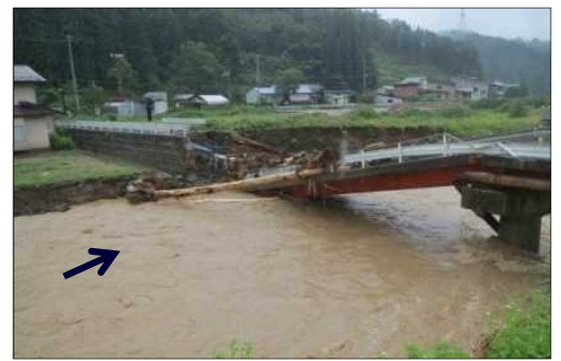
市道橋落橋状況
