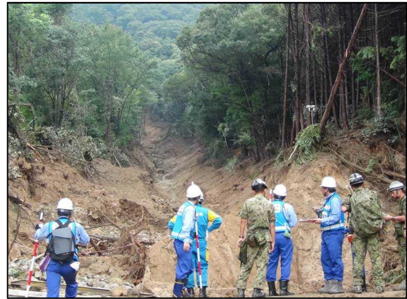
土砂災害発生現場の点検 （広島市土砂災害）（8月24日）
