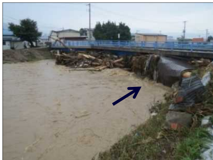
県道吉野橋 流木による河積阻害
