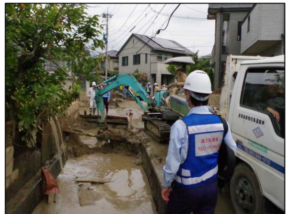
被災地の排水のための八木用水の土砂撤去の支援 （広島市土砂災害）（9月1日）
