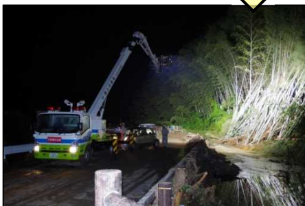
照明車による夜間作業の支援 （H26台風第12号・第11号による大雨）
