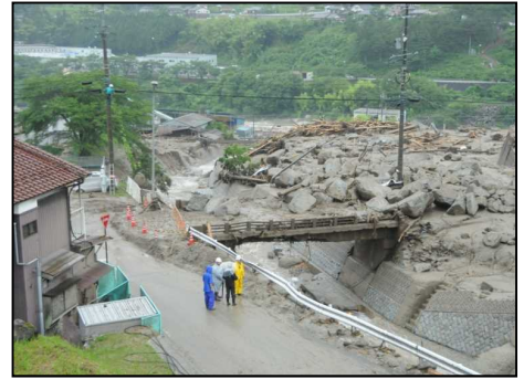
巨礫の氾濫状況
