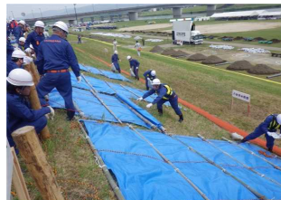
シート張工法による堤防保護(九州)
