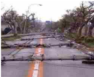
<電柱の倒壊による道路閉塞>
