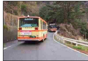
<大型車のすれ違いが困難な箇所>
