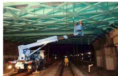
<跨線橋の計画的な点検>
