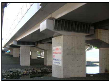
<橋梁の耐震補強>
