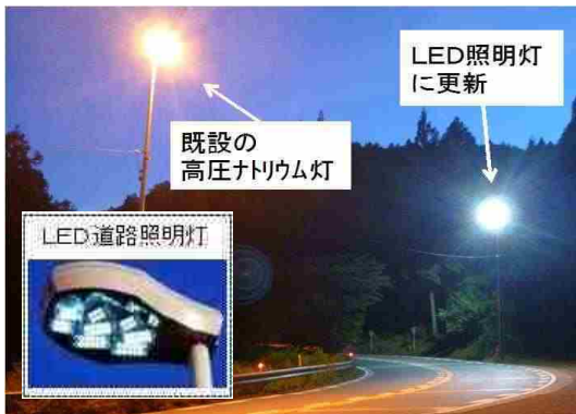
<LED道路照明灯の整備>
