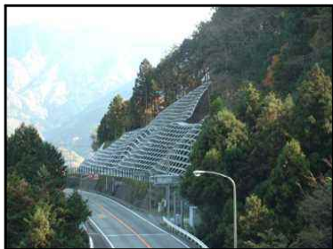
<斜面崩落防止対策>
