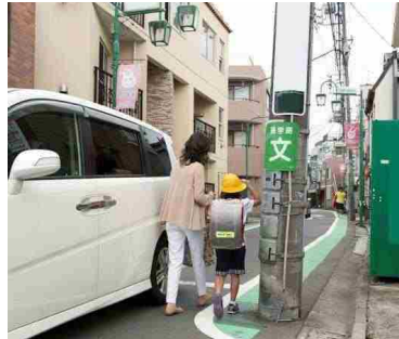
<歩行の支障となる電柱>
