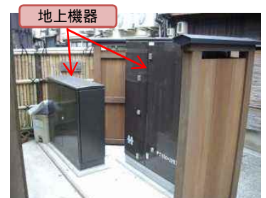
民地を活用した地上機器の設置
