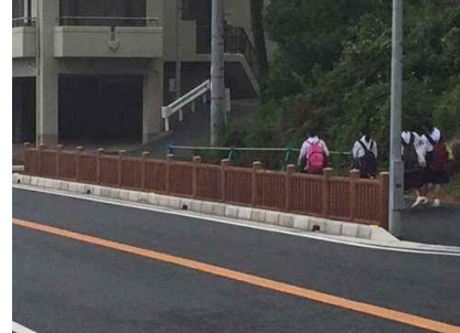
<木製の歩行者自転車柵> (国道28号・兵庫県淡路市)
