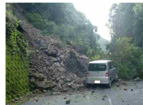
<災害時に通行不能となった箇所>
