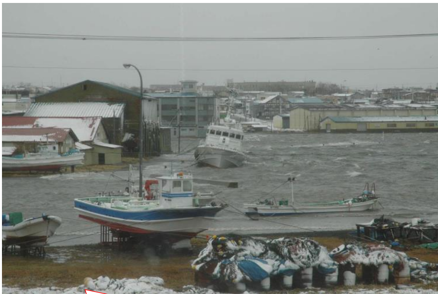
① 高潮等による堤外地の 資産への浸水被害
