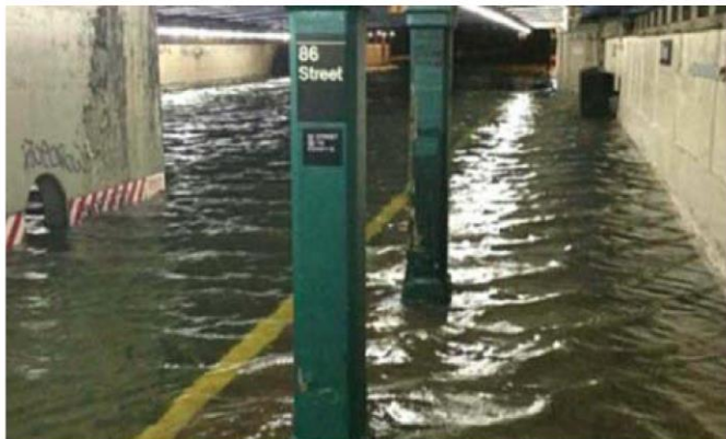
地下鉄86ストリート駅の浸水状況 ©MTA
