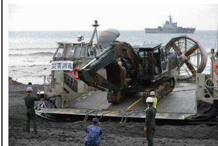
LCACによる重機の陸揚げ
