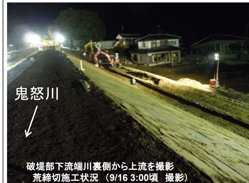
荒締切工 施工状況
