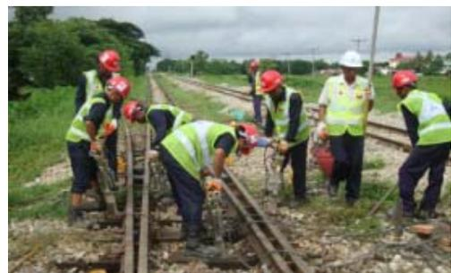
バラスト突き固めによる保守作業
