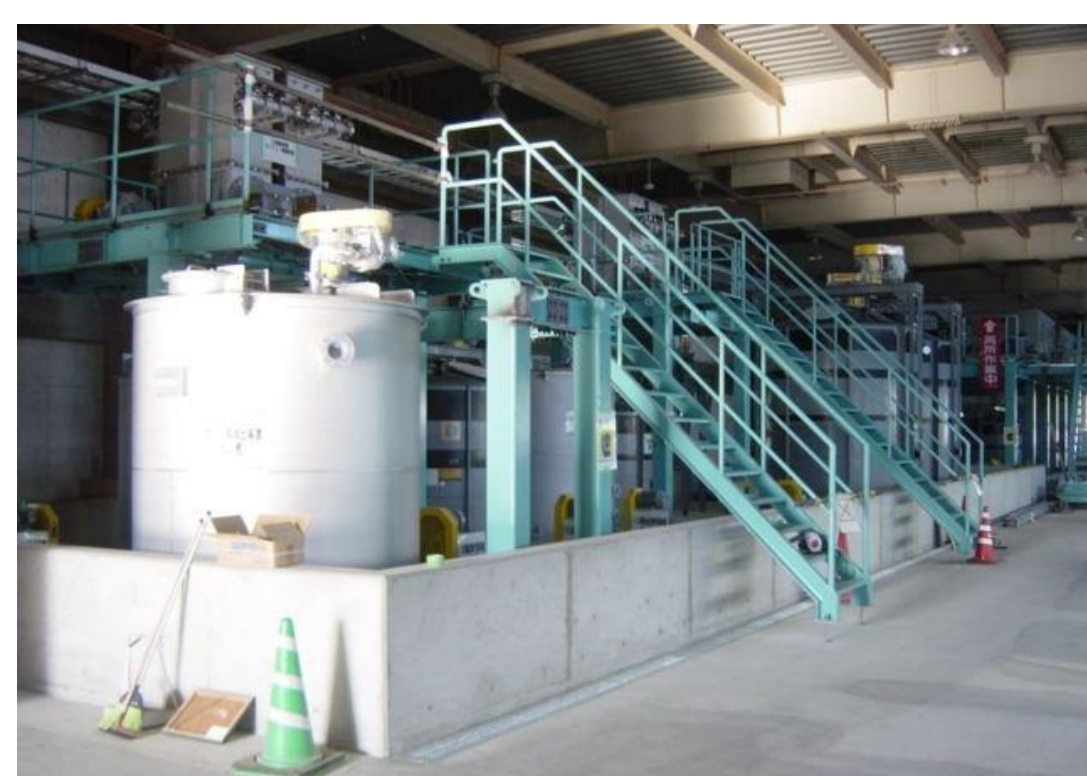
リン回収施設(例:岐阜市施設)
