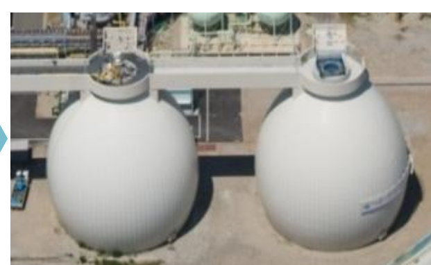
メタン発酵タンク
