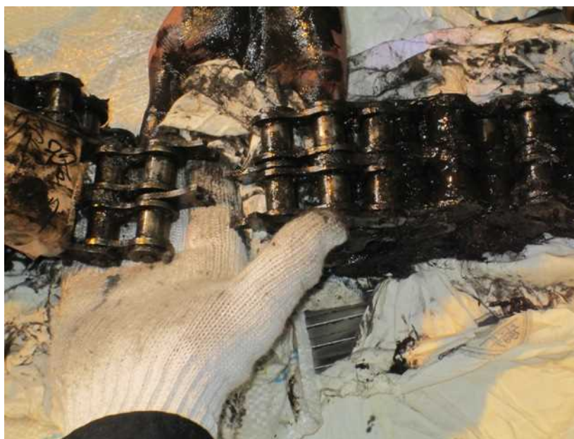
写真 I-1 駆動くさり破断部
