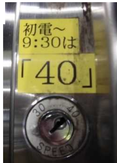
写真Ⅱ－3 速度切替操作部
