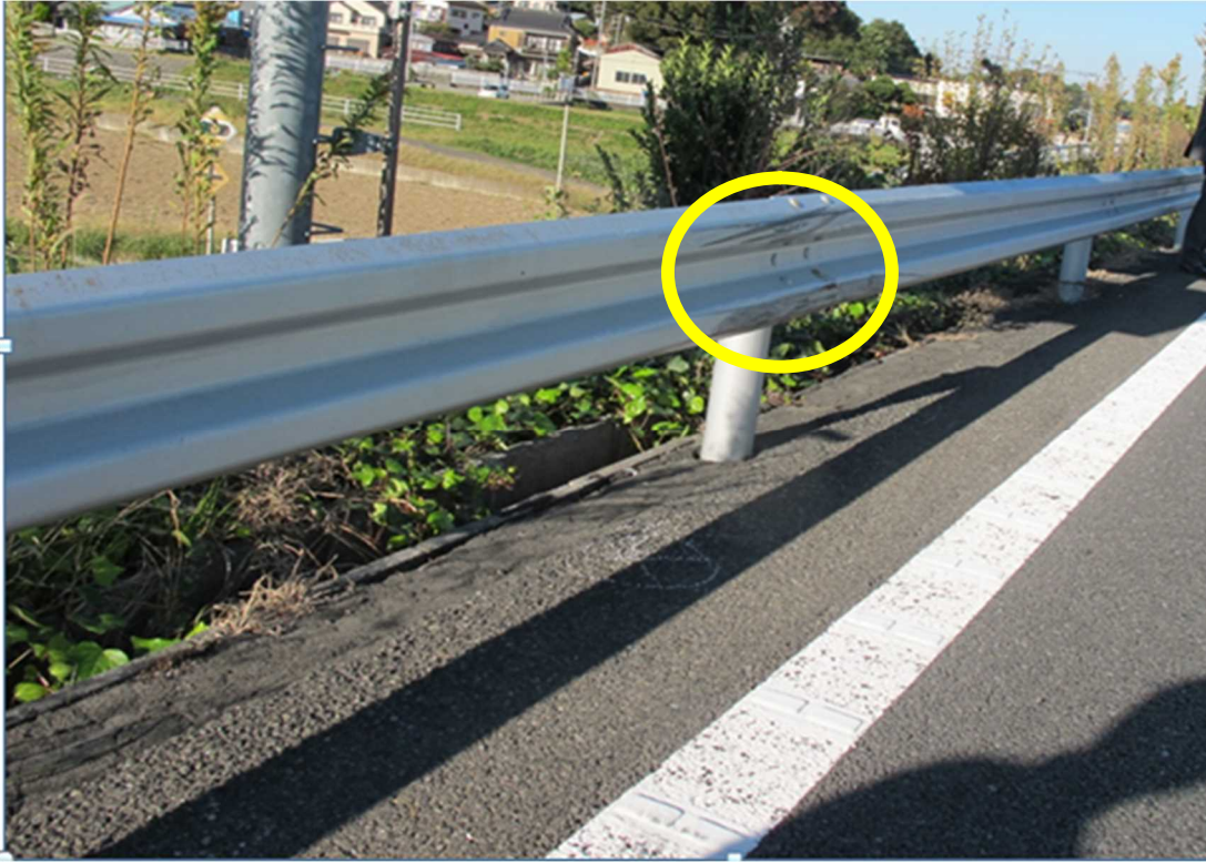
写真5 相手車両がガードレールに衝突した箇所
