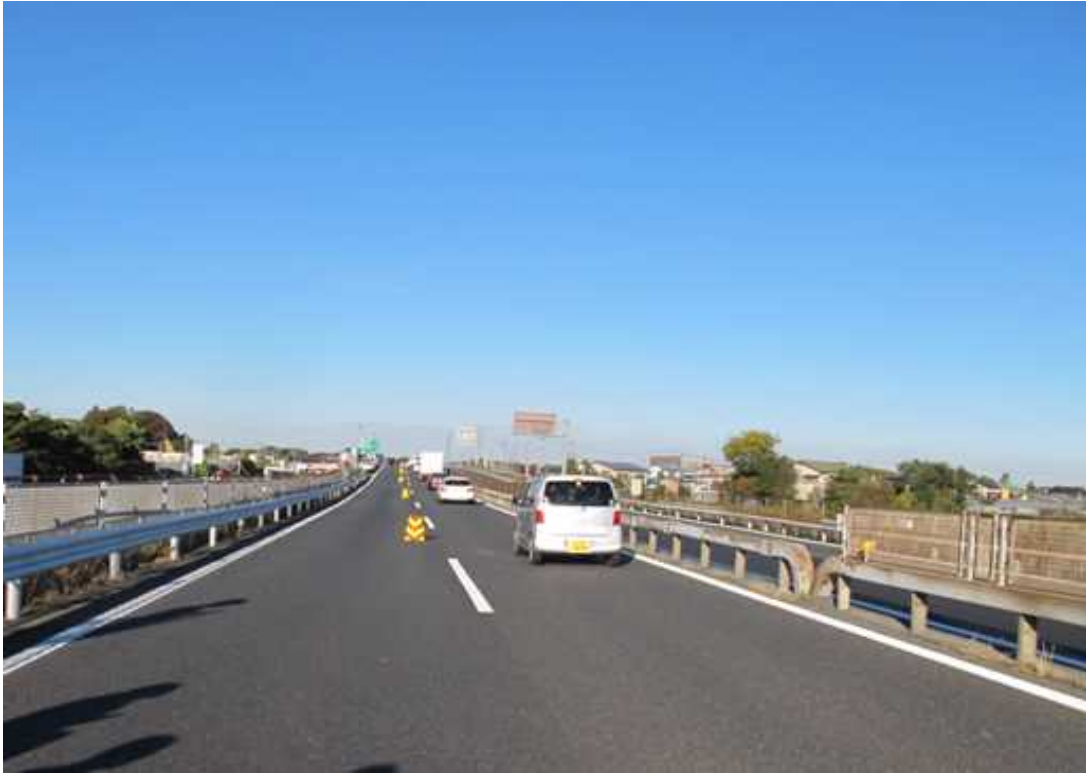
写真3 衝突地点手前約200m付近
