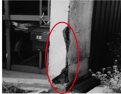
(例5) 外壁が破損している。
