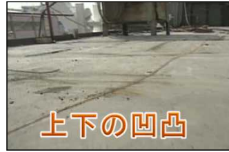
溶接後の変形歪み
