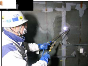
松葉焼き(凹凸形状の修正技術)
