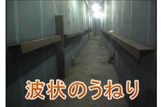
溶接後の変形歪み
