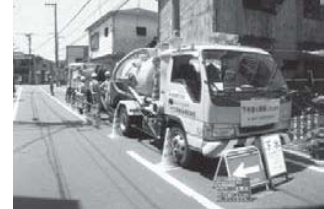
吸引車による下水道管の清掃
