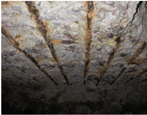
腐食により鉄筋が露出した状況
