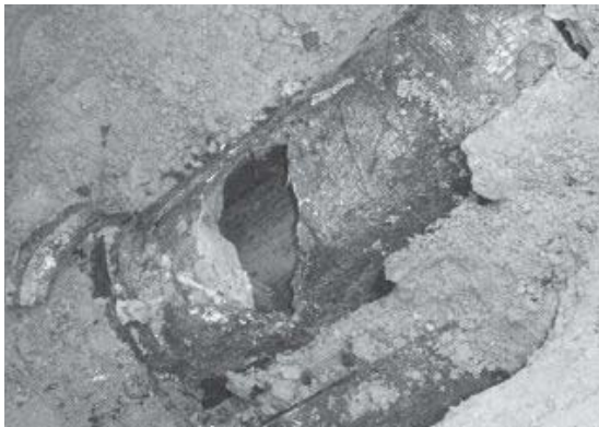
破損した取付管(Zパイプ)
