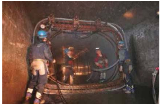
更生工法による幹線再構築（千川幹線）
