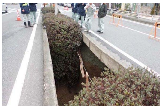
写真: 陥没状況(中央分離帯) 出展: 国土交通省資料
