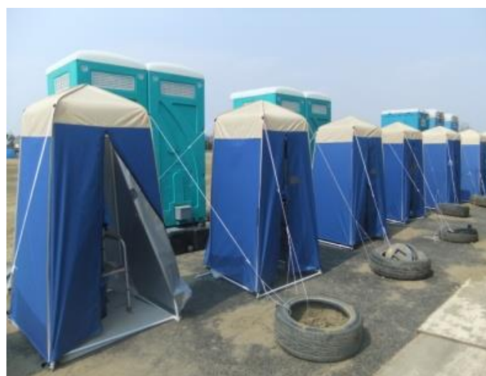
写真 1-1 東松島市で活躍したマンホールトイレ
