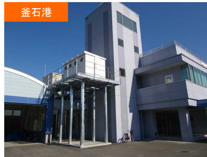
②電源設備の嵩上げ(釜石港)
