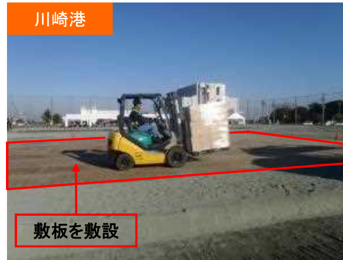
②敷板の敷設による作業用地の応急復旧(川崎港)
