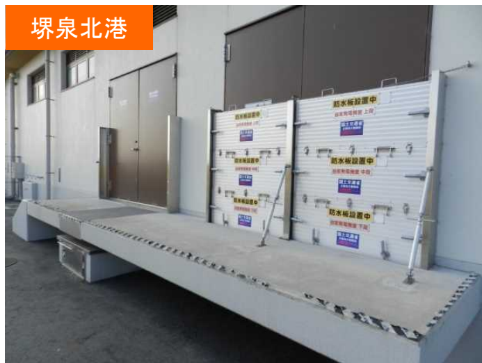
①備蓄倉庫への止水板設置(堺泉北港)
