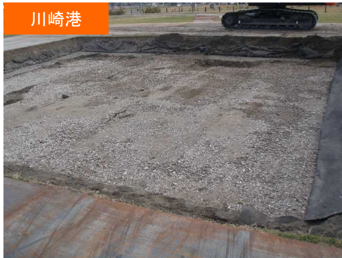
①緑地の下への砕石埋設(川崎港)
