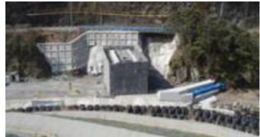
⑥水浦水路トンネル工事
