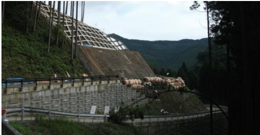
②付替林道工事
