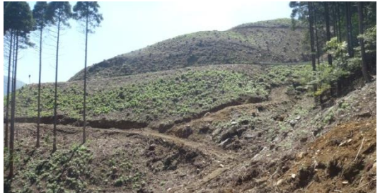
③ダムサイト左岸敷地造成
