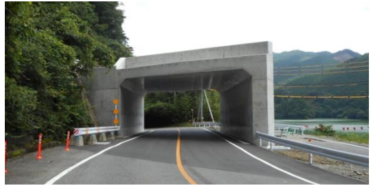
①付替国道工事
