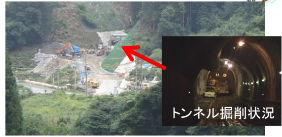
⑤利水放流トンネル工事
