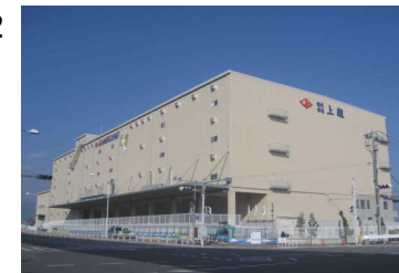
※写真は神戸港で既に営業中の同型の倉庫(KALC)
