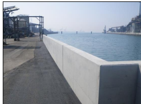
【護岸嵩上げ後】
