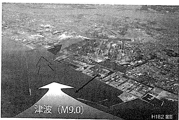
写真1 鹿島港の津波の被害 鹿島港は間口が広いが、奥が狭くなる人工のリアス式海岸。水深も奥が浅いため、津波の高さが増大する。
