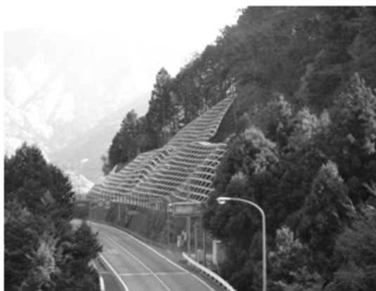
< 斜面崩落防止対策 >
