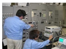
(航空保安施設点検実施状況)
