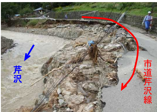
市道芹沢線の崩落状況
