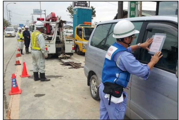
道路啓開による放置車両撤去（9月14日）
