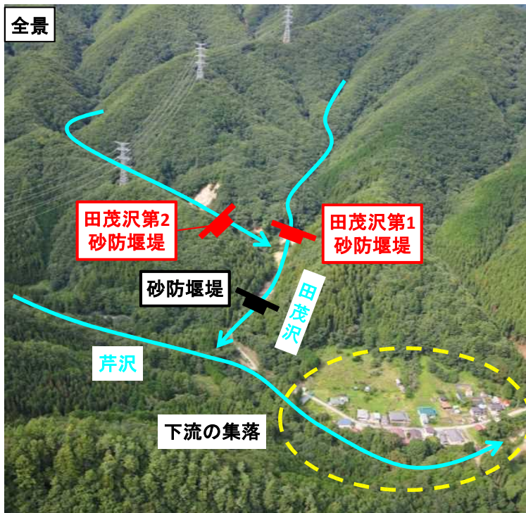
田茂沢第1砂防堰堤
