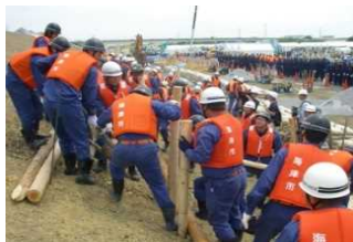
水防団による堤防保護(中部)
