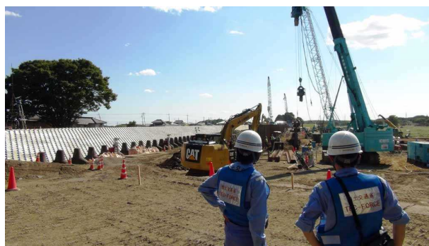
鋼矢板締切工の施行状況 (9月20日)
