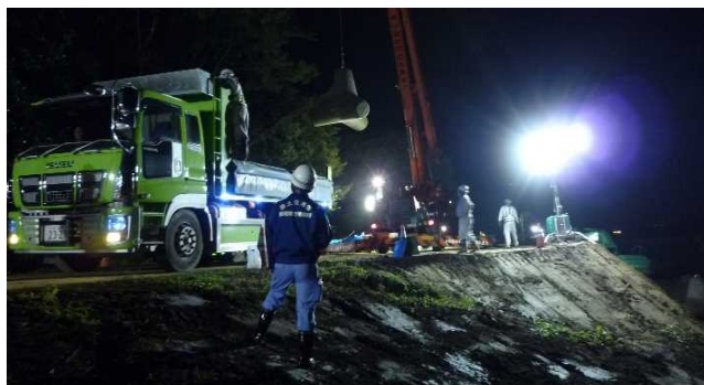
荒締切工の施工状況 (9月12日)
