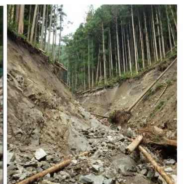
土石流流出状況(中坪上沢)
