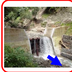
土石流発生直後 (H27.9.11)
