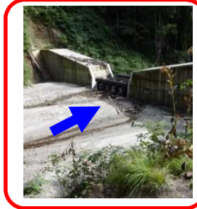
土石流発生直後 (H27.9.11)
