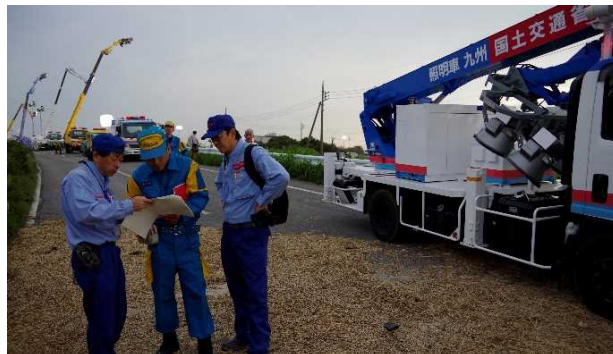
夜間作業に向け搜索活動関係機関と照明車位置を協議 (9月13日)
