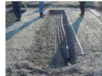
ケーブル敷設【碎石】
