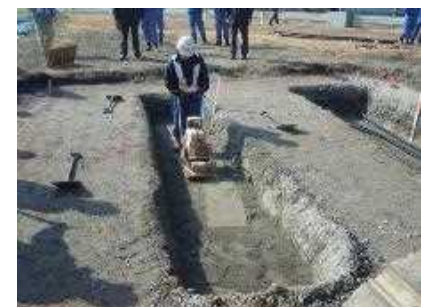
転圧状況【プレート】
