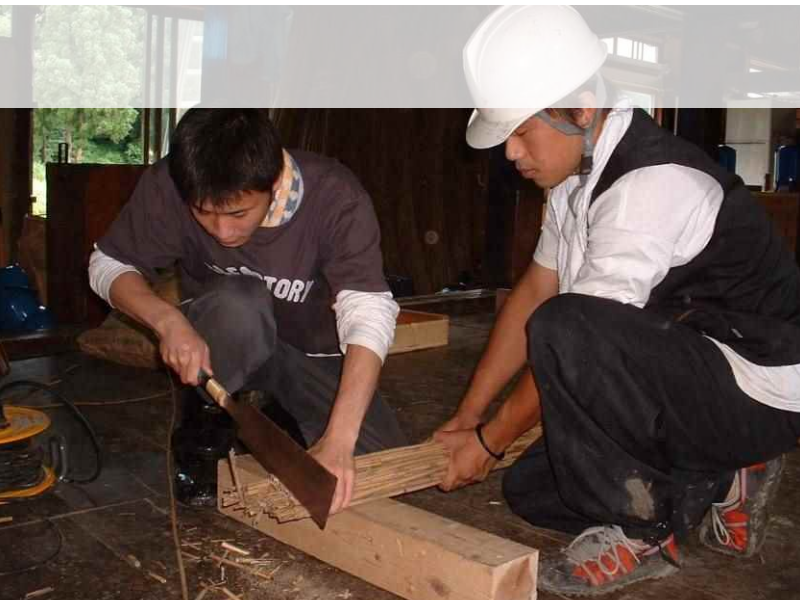
古民家改修実習
