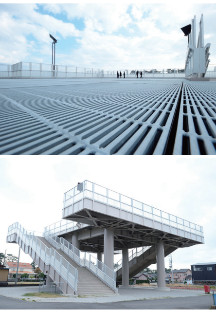
公園跡地に建設された津波避難タワー。建築基準法の工作物とするため、床をメッシュ構造にした。空に向けて設置されているのは太陽光パネル。ソーラー発電式の夜間照明設備3日分程度の電力を充電できる。
