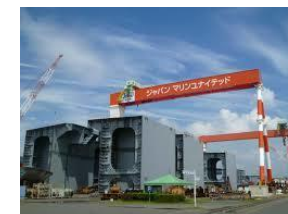
大型クレーン導入による工期短縮
