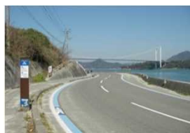
自転車走行レーンの表示 (ブルーライン)
