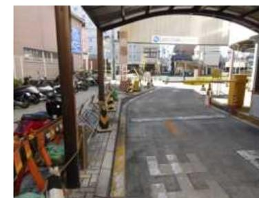
出庫ゲートバーを短くカットし、自動二輪車が通ることができるよう改修(右)
