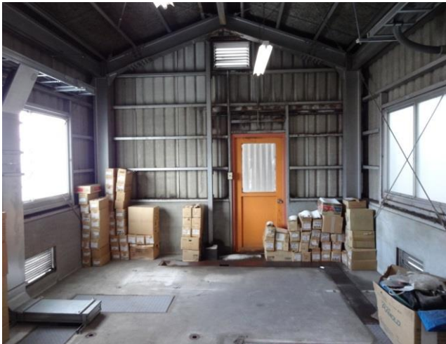
①当初あった受電設備の設置場所 (上屋内)
