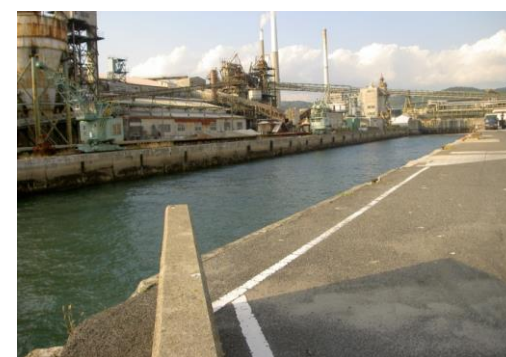
②防潮堤整備及び嵩上げ
