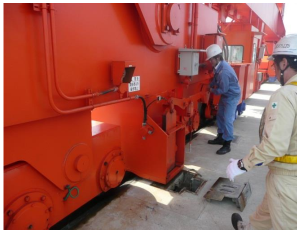
①荷役機械の転倒防止対策 (転倒防止アンカー固定)
