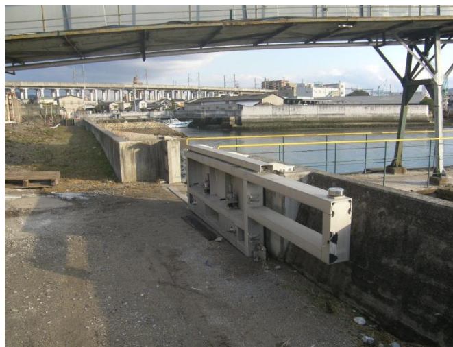
②防潮堤整備及び嵩上げ
