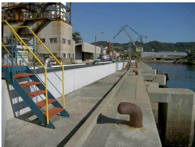
②防潮堤整備及び嵩上げ
