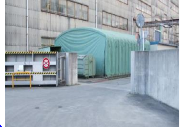
②防潮堤・防潮壁の整備
