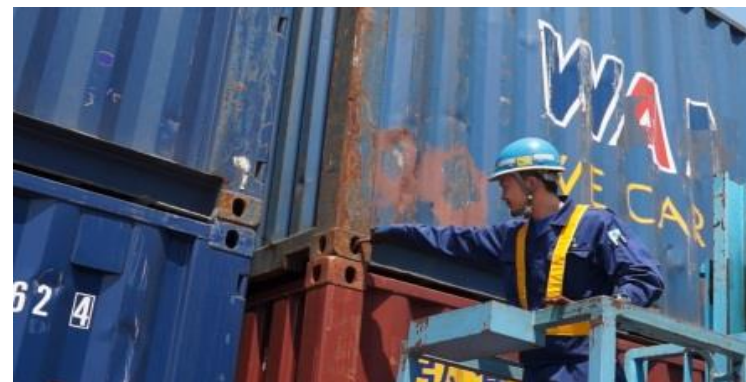
③コンテナ転倒防止対策 (ブーメラン設置)
