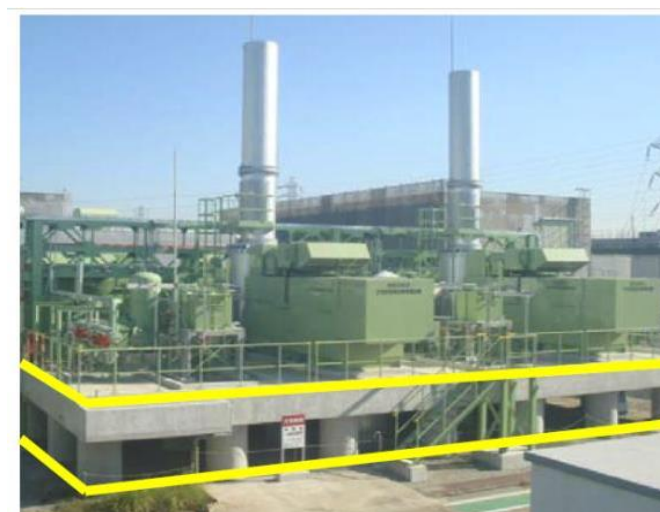
② 非常用発電設備の嵩上げ(浸水対策)
