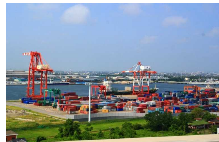
図 24 国際物流ターミナル整備(伏木富山港)
