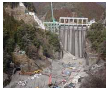
写真2 長安ロダム改造事業 (徳島県那賀町)
