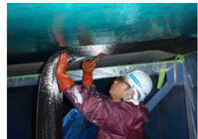
写真9 橋梁の修繕状況
