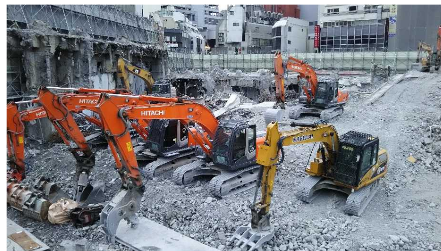
<解体工事の現場例>
