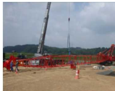
クローラークレーン組立状況
