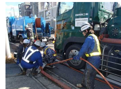
側溝清掃作業状況
