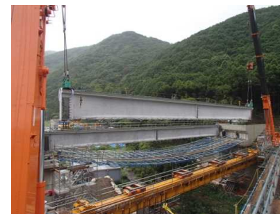
主桁架設状況
