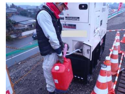
発動発電機給油状況
