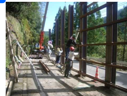
防護柵設置状況
