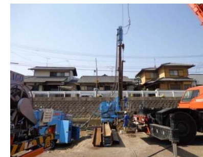
鋼矢板圧入状況
