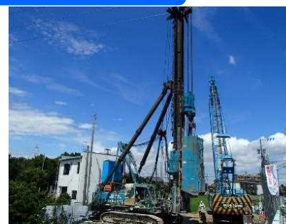
杭施工状況(杭打機)
