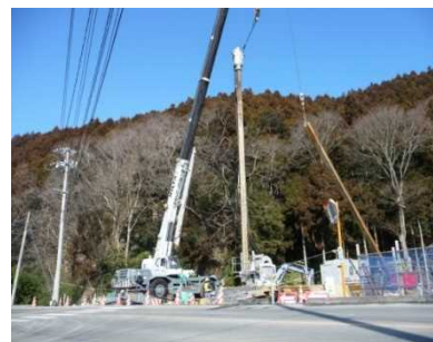
鋼矢板吊り込み状況
