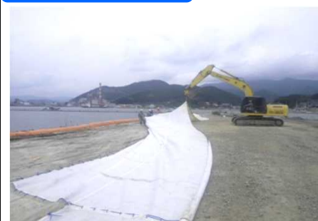
フェンス組立状況
