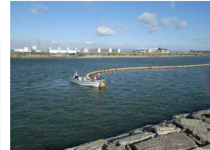
フェンス設置状況
