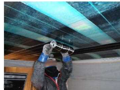
炭素繊維シート接着状況
