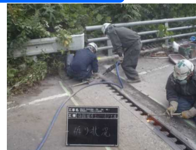
旧伸縮装置撤去状況
