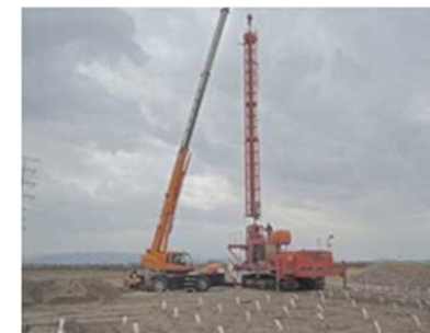
地盤改良機械組立状況
