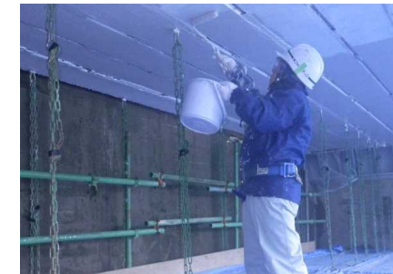
仕上げ塗装状況
