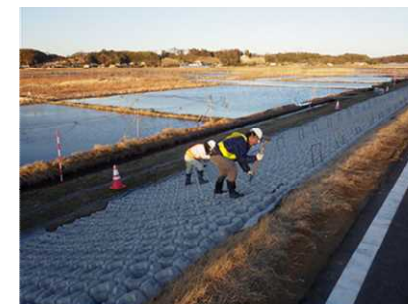
アンカーピン打設状況
