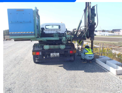
中間支柱打込状況
