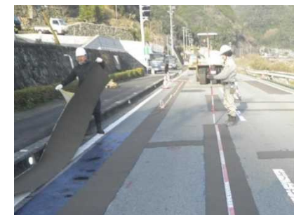
クラック防止シート張り状況
