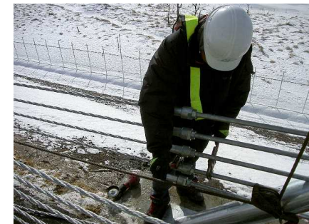
ケーブル張施工状況
