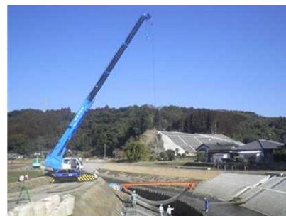
ブロックマット据付状況
