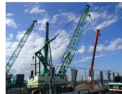
杭施工状況(クローラクレーン)
