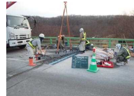
伸縮装置据付状況
