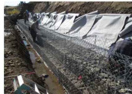
かご組立・据付状況
