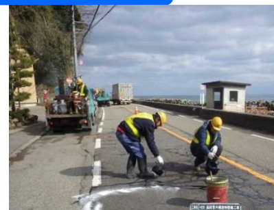
注入材注入状況
