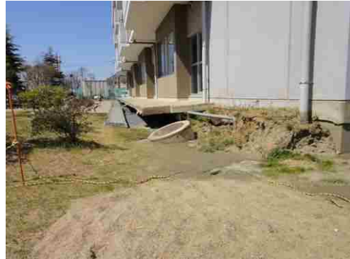
写真3-4 建物の基礎地盤の沈下 6)
