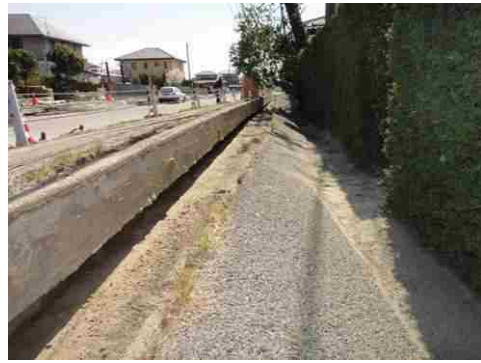
写真3-6 道路側溝の破壊と蓋の乗り上げ 6)
