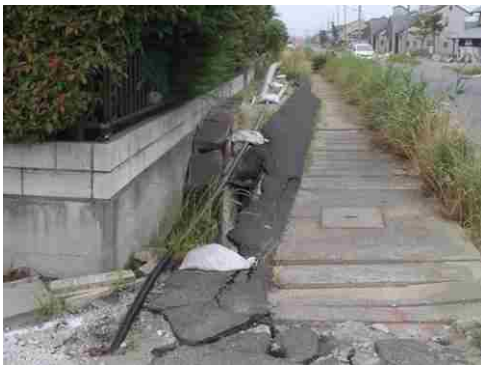
写真3-7 ライフラインの押し上げ現象 6)
