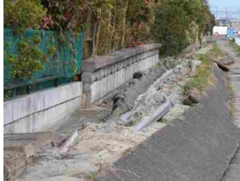
写真3-7 ライフラインの押し上げ現象 6)
