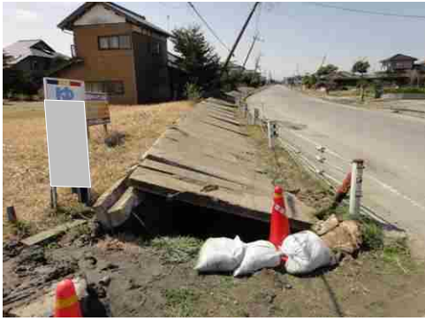
写真3-6 道路側溝の破壊と蓋の乗り上げ 6)
