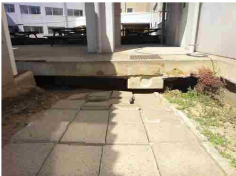
写真3-4 建物の基礎地盤の沈下 6)
