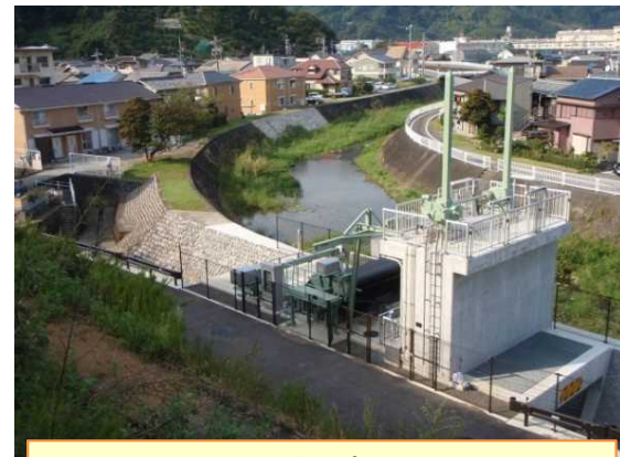
丸子芹が谷雨水ポンプ所完成(H25.11)
