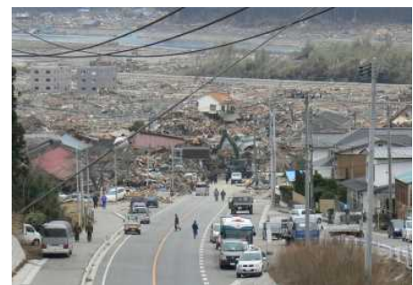
図5 東日本大震災による被災状況 (岩手県陸前高田市)
