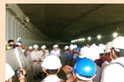
平成23年10月 合同現場見学会(ベトナム)
