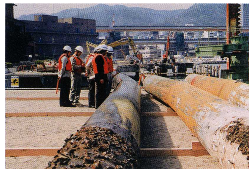
写真-2 引抜かれた棧橋の鋼管杭
