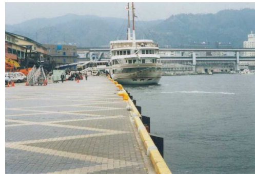
写真-1 棧橋の被災例
