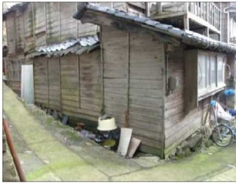
外壁が裸木造の例
