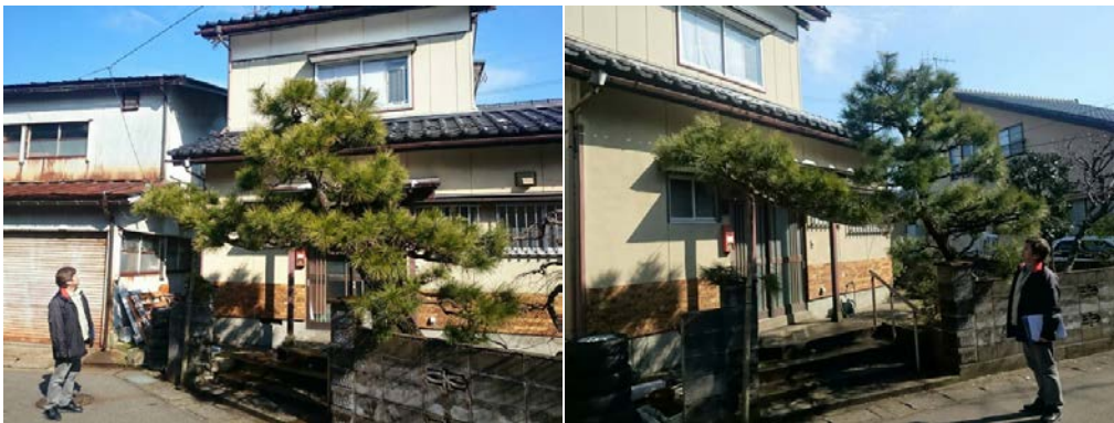
写真 1 1 劣化診断時の写真
