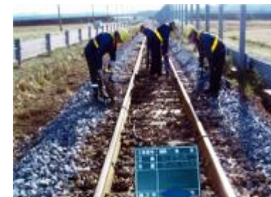
レールの修繕
