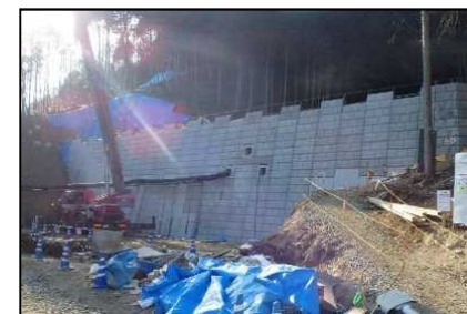
砂防堰堤の整備(広島市安佐南区八木4丁目)
