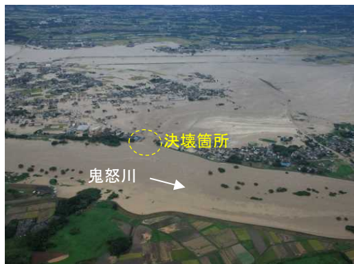
浸水被害の状況
