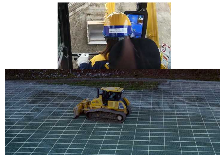
ICT建機による施工
