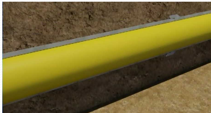
②空気圧で拡張させる
