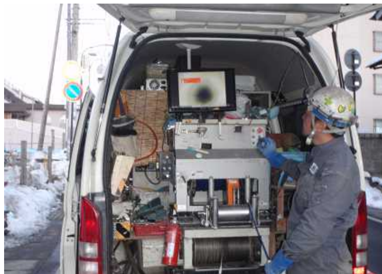
④管更生内面検査
