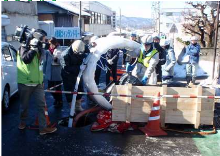
①採熱パイプ 架橋ポリエチレン管 10Φ×14本挿入
