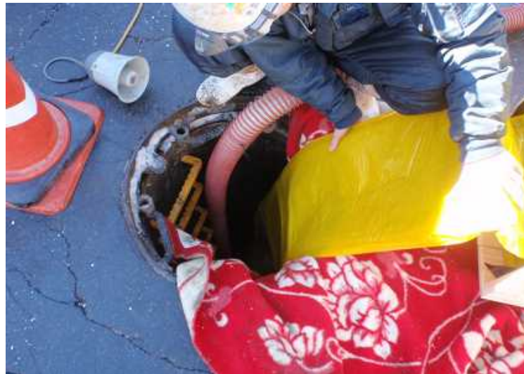
②管更生ライナー材料挿入(膨らます前)
